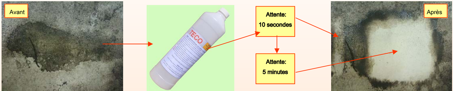
Très vieille tache de graisse en atelier sur béton peint > Vaporisation du TECO mélangé 3 fois son volume d'eau > Attente de 5 mn environ > Brossage léger > Rinçage
